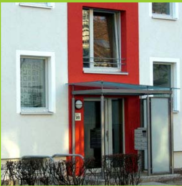
Bild 3.3 – Sanierung; Quelle: Architekturbüro pk nord
