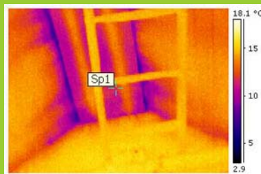
Bilder 5.5 und 5.6 – Durchführung eines 3. Briefing; Thermografie-Aufnahmen; Quelle: GMW – Ingenieurbüro GmbH
