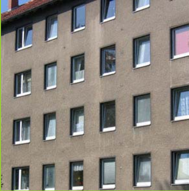
Bild 3.1 — Bestandsfassade; Quelle: Architekturbüro pk nord
