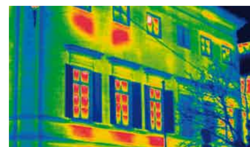
Nicchie sottofinestra non isolate dove alloggia il calorifero, difetti nella muratura
