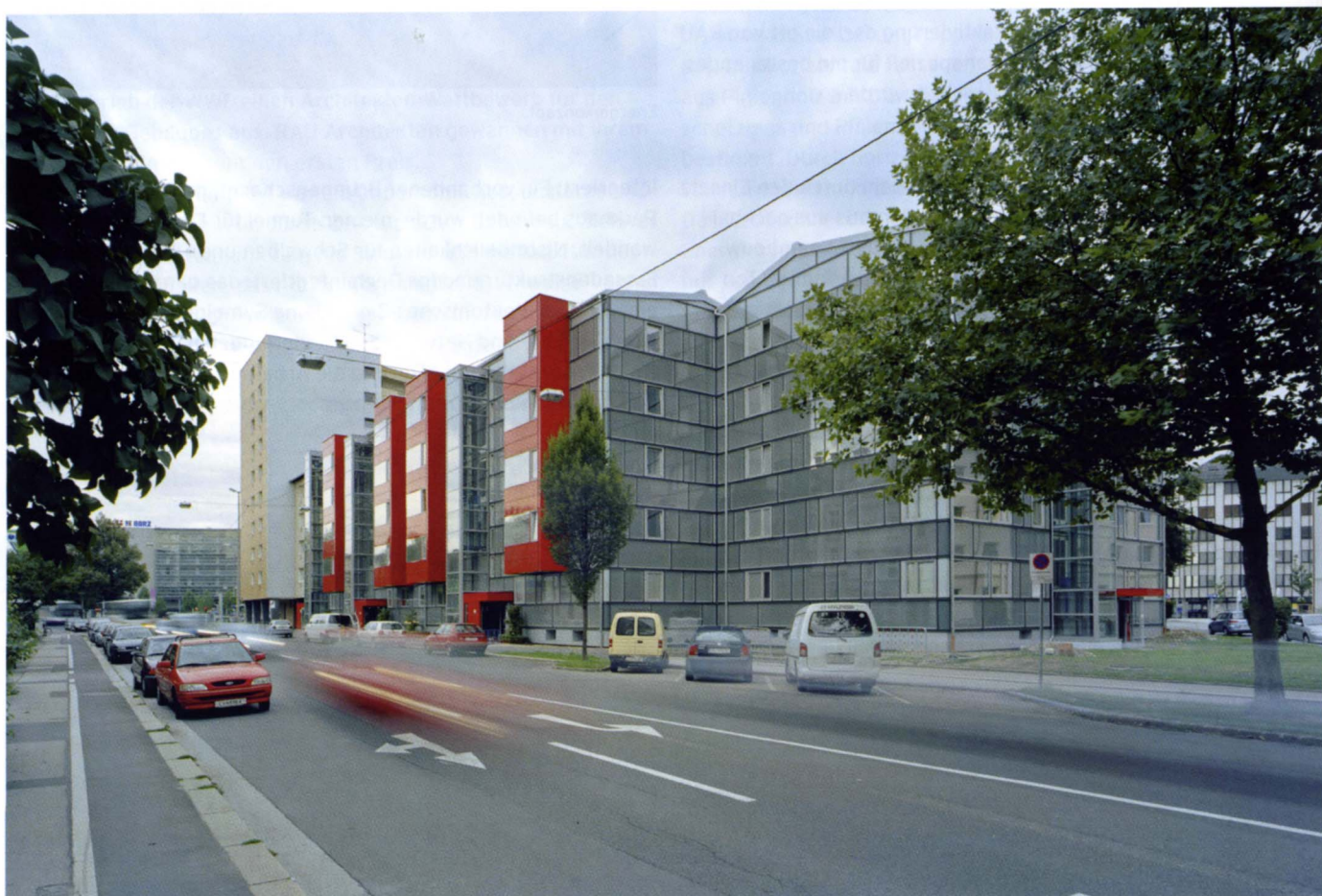
Mehrfamilienhausblock in Linz, Österreich, nach der Sanierung 2006.
