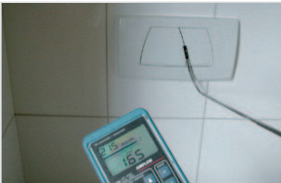
Abb. 13 Überprüfung der Luftdichtheit – Wärmeabströmung durch eingebaute Armaturen, Messung mittels Anemometer
