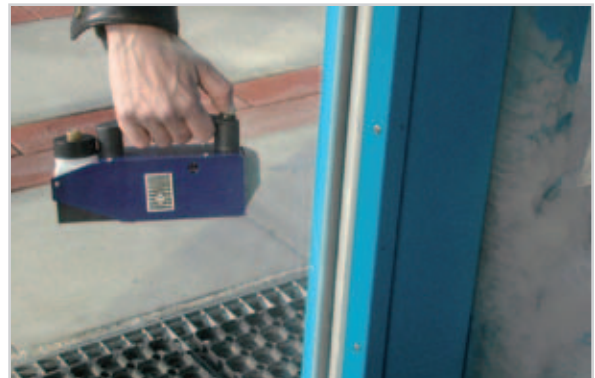
Abb. 14 Überprüfung der Luftdichtheit – Wärmeabströmung Luftundichtheiten in Fensterrahmen, Visualisierung mittels Nebel
