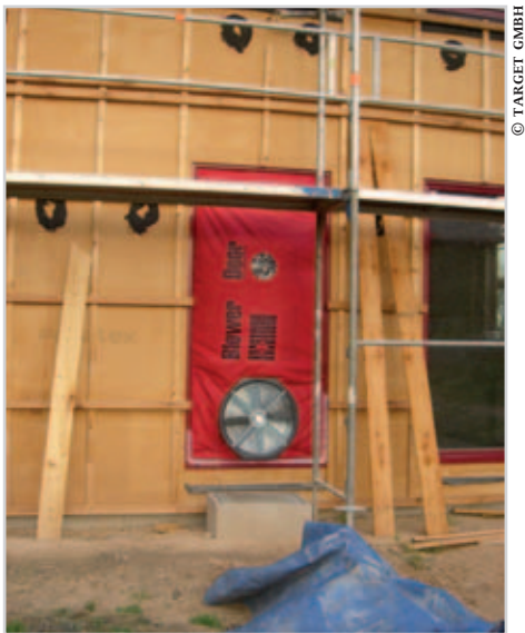
Abb. 16 Luftdichtheitsmessung während der Ausführungsphase
