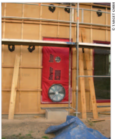
Photo 3 Prova di ermeticità durante la fase di costruzione [1]
