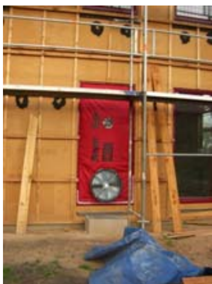
Test szczelności w czasie budowy
