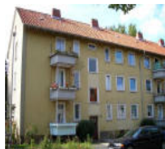
Bilder oben: Vor der Sanierung
