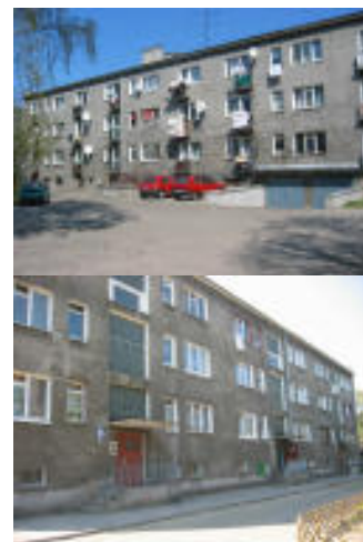
Bilder oben: Vor der Sanierung
