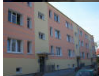
Sopra: Dopo la ristrutturazione
