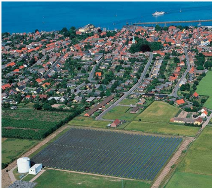
Solare Nahwärmanlage in Marstal, Dänemark 17,000 m 2 Kollektorfläche
