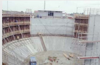
12,000 m 3 Saisonspeicher im Bau Friedrichshafen
