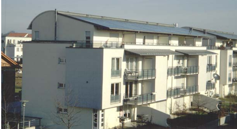
Bild 4: Kollektorfeld in Neckarsulm - Eugen-Bolz-Straße (360 m 2 )
