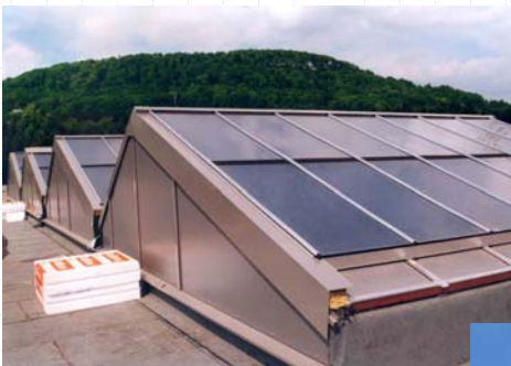
Aufbaukollektor auf Shed optisch angepasst
