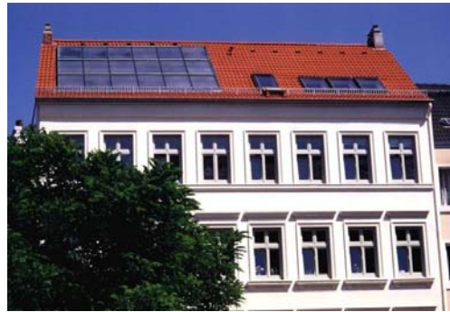
Integration der Solarthermie im Gebäudebestand
