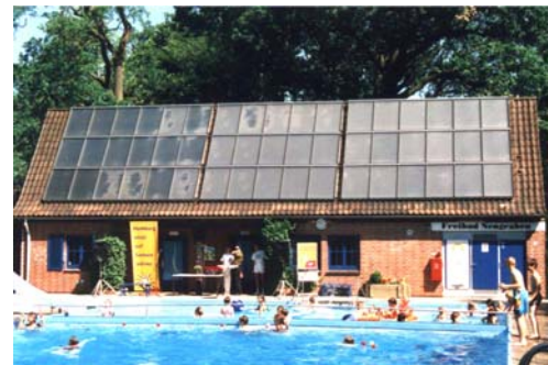
Solaranlage Freibad Neugraben
