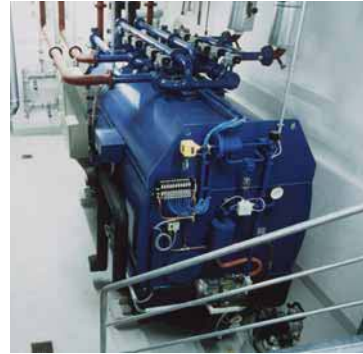
Nishiyodo NAK 70 kW Nennkälteleistung Installation: Universitäts-Klinikum Freiburg
