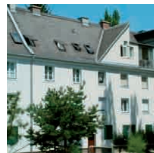
vor der Modernisierung
