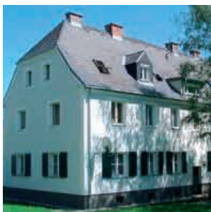
nach der Modernisierung
