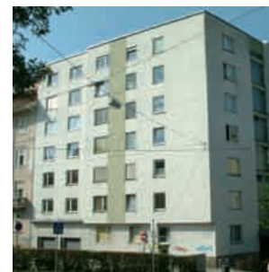
vor der Modernisierung
