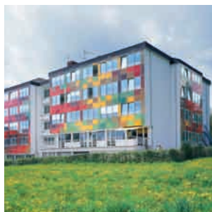
nach der Modernisierung
