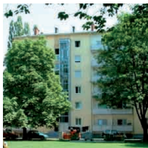
nach der Modernisierung
