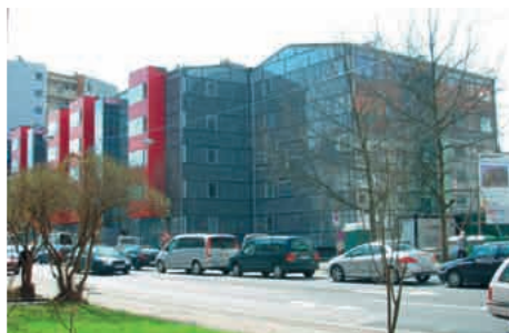
nach der Modernisierung
