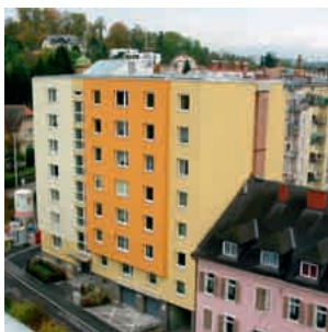
nach der Modernisierung
