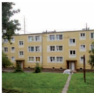
nach der Modernisierung
