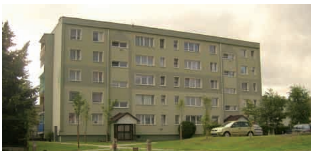
nach der Modernisierung
