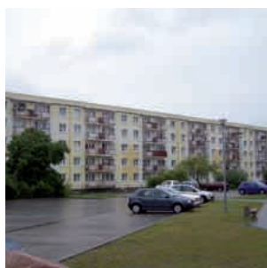
nach der Modernisierung
