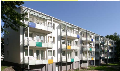
nach der Modernisierung
