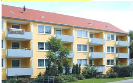
nach der Modernisierung
