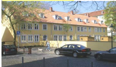
nach der Modernisierung
