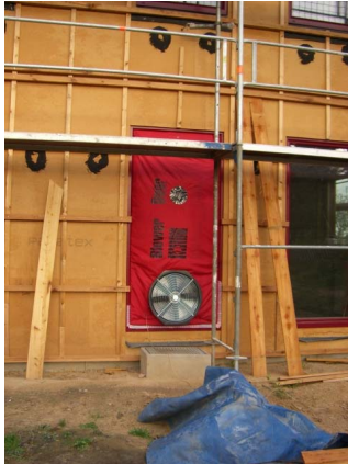
Luftdichtheitsmessung während der Ausführungsphase
