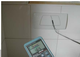
Überprüfung der Luftdichtheit – Wärmeabströmung durch eingebaute Armaturen, Messung mittels Anemometer
